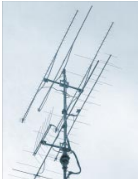
Bild 7: ATV-Antennenanlage von DJ6PI
