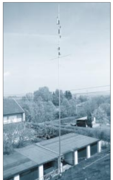
Bild 3: Die erhöht und abgespannt aufgebaute Antenne R 5 für die Amateurbänder von 10 m bis 20 m
